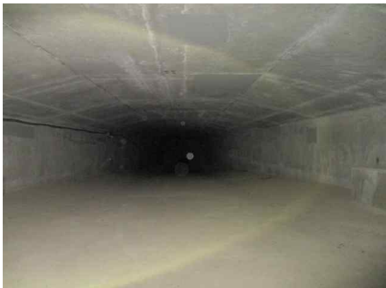
PSC BOX 거더 내부 전경
