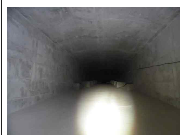
PSC BOX 거더 내부 전경
