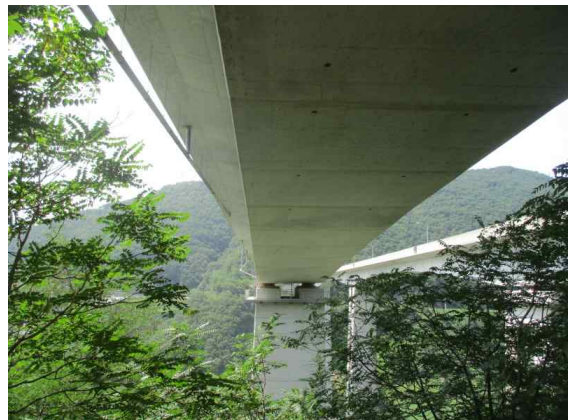
PSC BOX 거더 외부 전경
