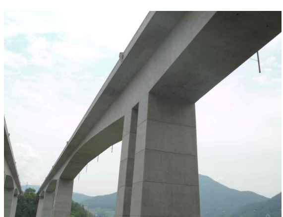
PSC BOX 거더 외부 전경
